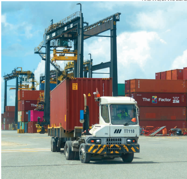
Puerto Multimodal Caucedo en Santo Domingo.
