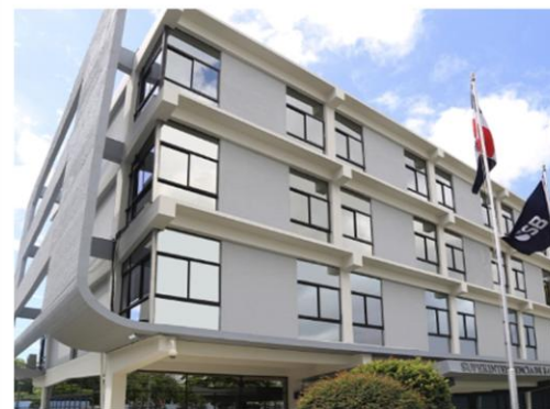
Fachada de la Superintendencia de Bancos. / ARCHIVO/LD
