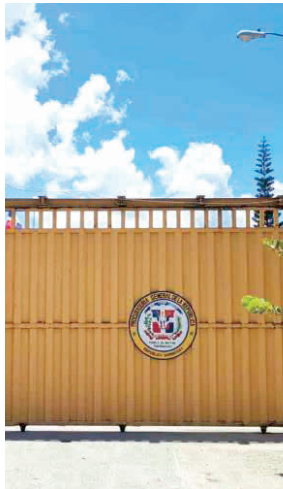
Entrada de la cárcel El Pinito, de La Vega.
