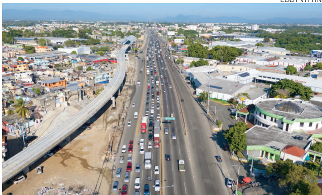
Vista parcial de la autopista Duarte.
