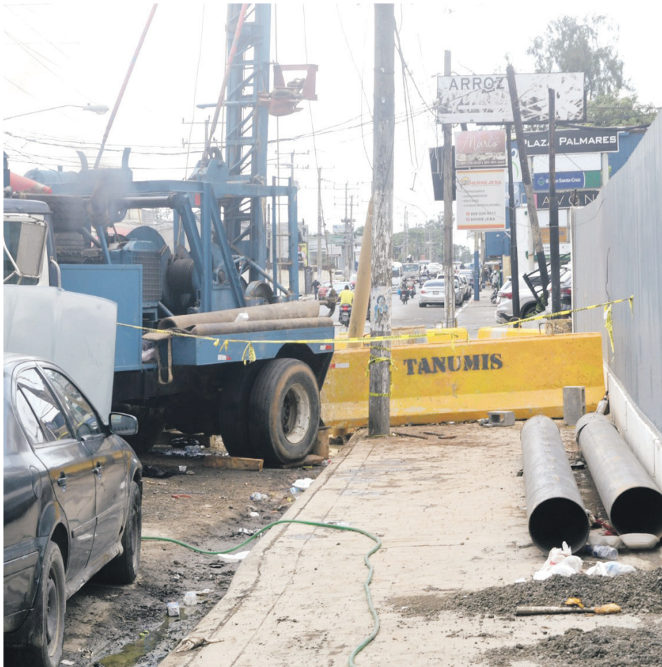
Brigadas de Obras Públicas trabajaban ayer en la avenida Isabel Aguiar. LEONEL MATOS /LD
