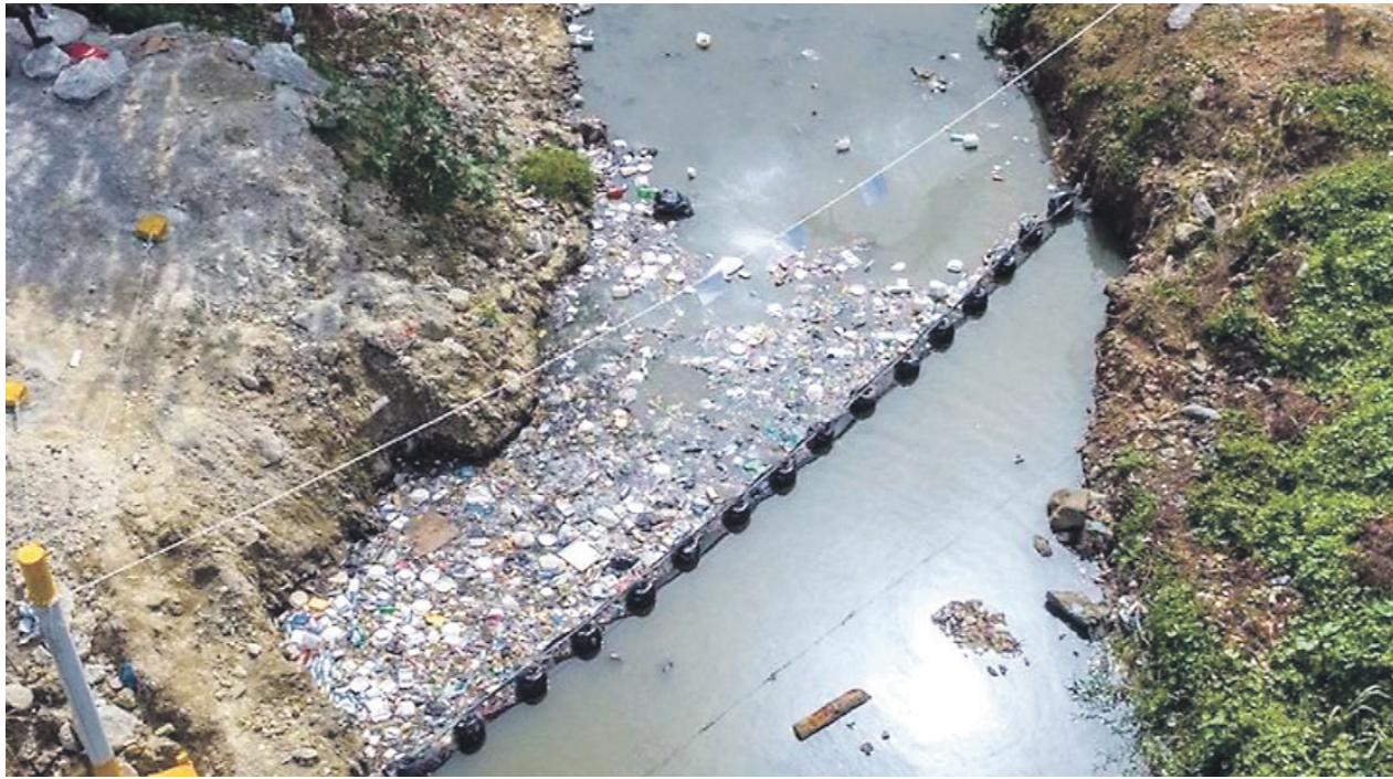
En la imagen, una estructura de biobardas retiene desechos de todo tipo que avanzaban sobre una masa de agua.
